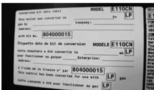
a. Étiquette de conversion gaz par-dessus la plaque signalétique (exemple)
